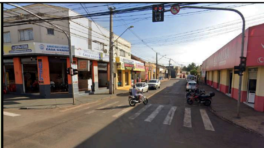
ESQUINA DA R. EQUADOR COM R. BELO HORIZONTE. FONTE: GOOGLE MAPS. ACESSO EM 25/10/2023
