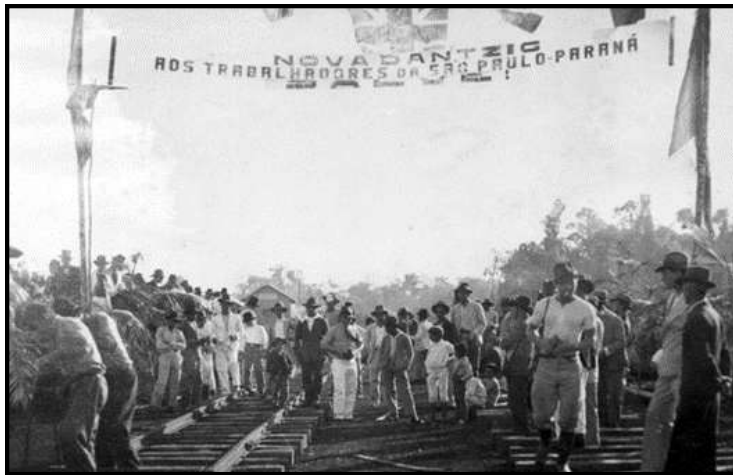
CHEGADA DOS TRILHOS DA ESTRADA DE FERRO A NOVA DANTZIG, EM 15/08/1935. MHC.
